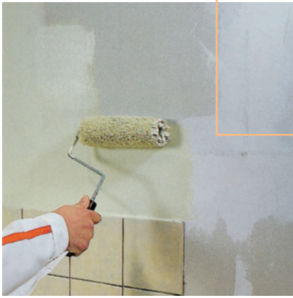
Tapezieren oder Streichen ohne vorherige Grundierung
