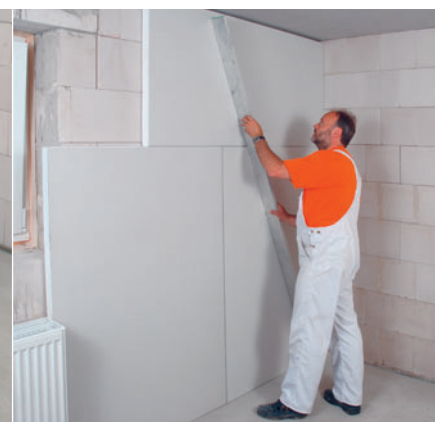
Andrücken und Ausrichten mit dem Richtscheit
