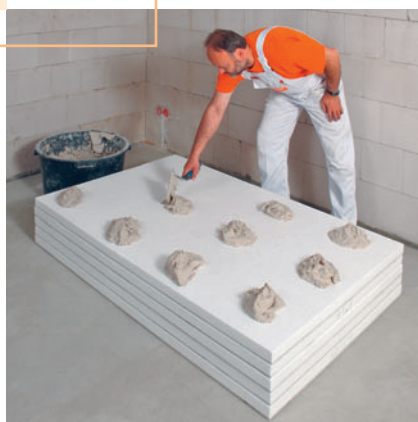
Ansetzbinder batzenförmig auf die Rückseite auftragen
