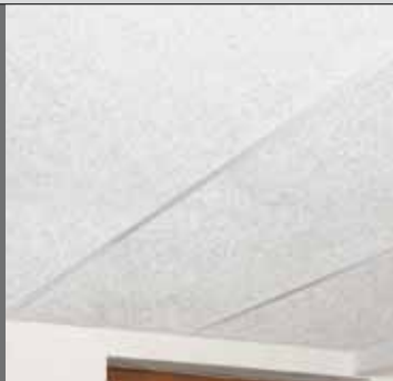
Fertige Deckenansicht gleicht damit der Schienenmontage
