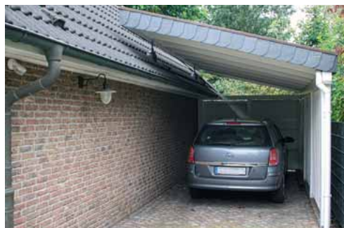
Wegen niedrigem Dachüberstand einfach mit unserer patentierten Auf-Dach-Lösung realisiert.
