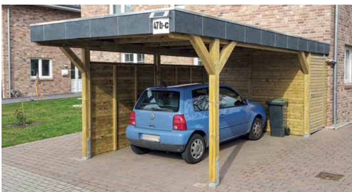
Umlaufende Echtschiefer-Fassadenblende bei einem klassischen Kiefer KDI Carport mit Rhombus-Kammer.
