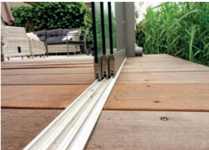
Glasaufnahme der Führungsschiene max. 5 Scheiben.
