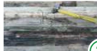
Entfernen von Nägeln, Schrauben und anderen Verbindungselementen
