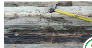
Entfernen von Nägeln, Schrauben und anderen Verbindungselementen
