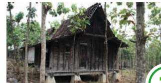
Abriss des Holzhauses
