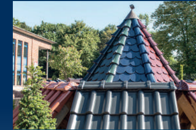
Çatı ve dış cephe
